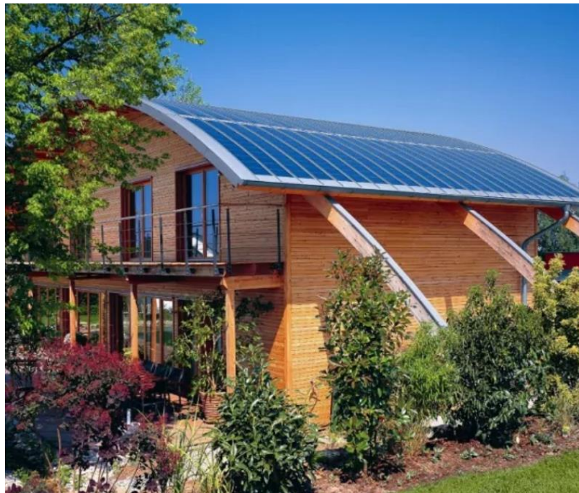
Рисунок 9.3 – Гнучкі сонячні панелі на даху будинку, що виконують роль покрівельного матеріалу
