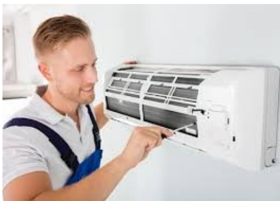
Рисунок 2.5 – Робота майстра по встановленню кліматичного обладнання
