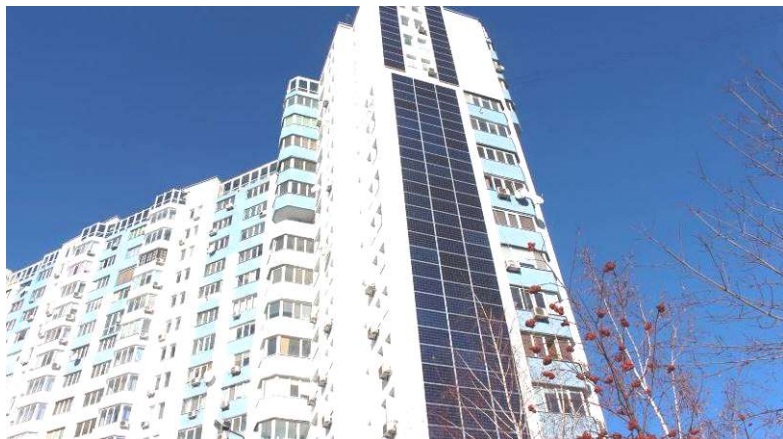
Рис. 3. Розміщення сонячних панелей на стінах будівлі
