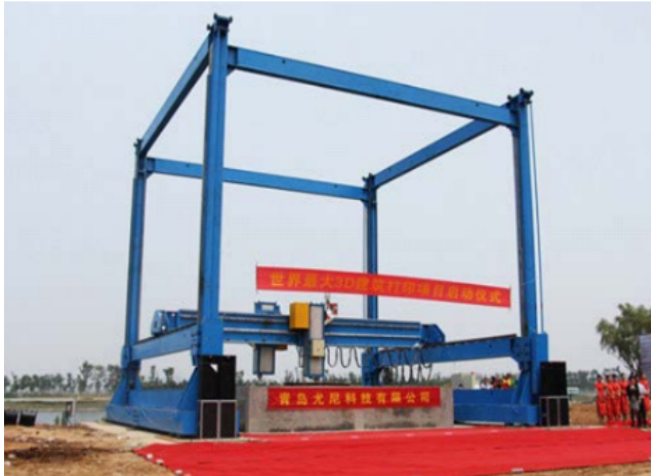
Рисунок 1 — Будівельний 3D - принтер в Циндао.
