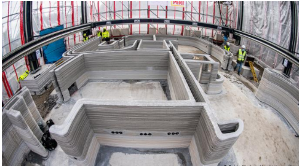
Рисунок 17 — Процес друку стіни
