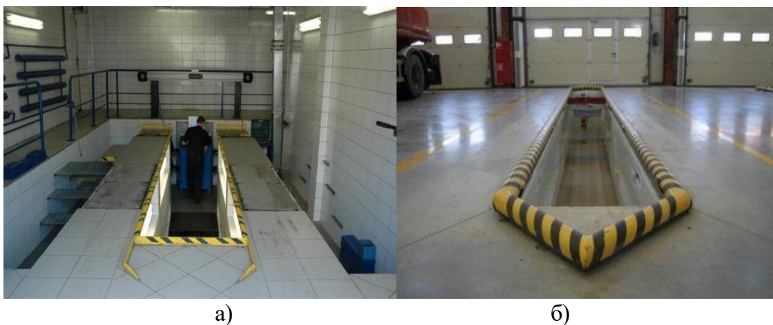
Рис. 3.2 Тупикові та проїзні оглядові канави. а – тупикова; б – проїзна;
