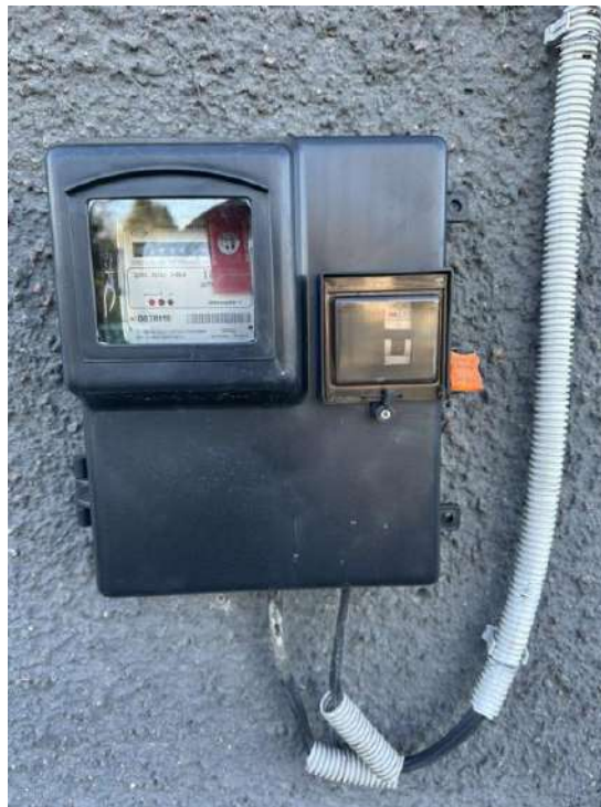
Рисунок 3.3 – Лічильник електричної енергії
